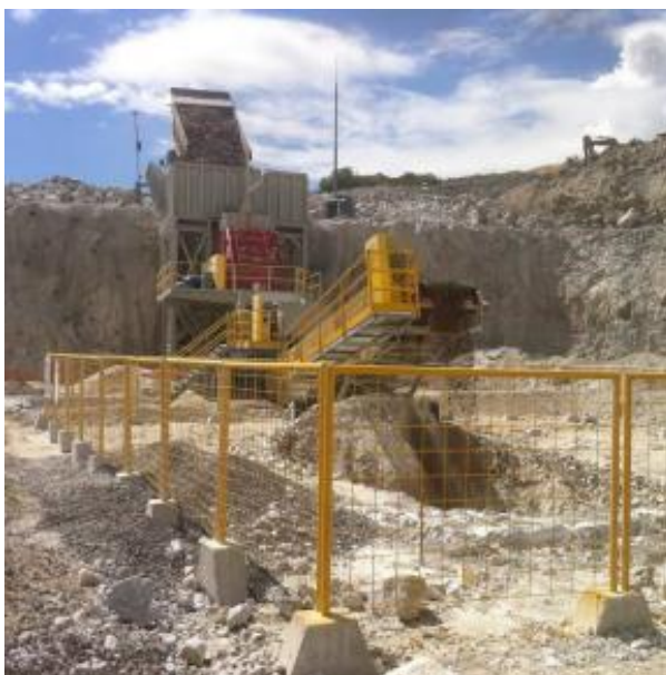
Figura 18. Chimenea vertical en las Minas de Selva Alegre – Provincia de Imbabura
