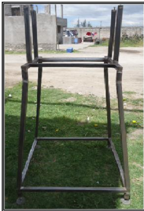
Fuente: Grupo de investigación Figura 4.44 Estructura de soporte del reactor
