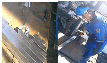
Figura 4.2 Trazado y corte del tubo para la construcción
