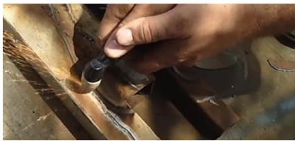
Figura 4.4 Cortando metal para la base del motor reductor
