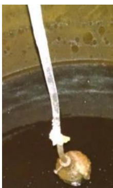
Figura 39. Sensor tipo boya de los tanques de sulfato.
