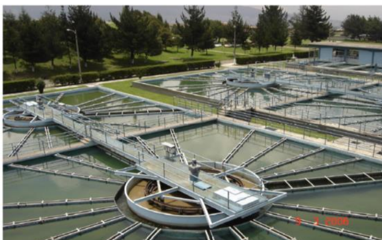
Figura 4. Planta de Tratamiento Puengasí.
