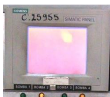
Figura 45. Touch panel para control del área de sulfato de aluminio.
