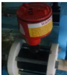
Figura 43. Caudalímetro del área de sulfato de aluminio.
