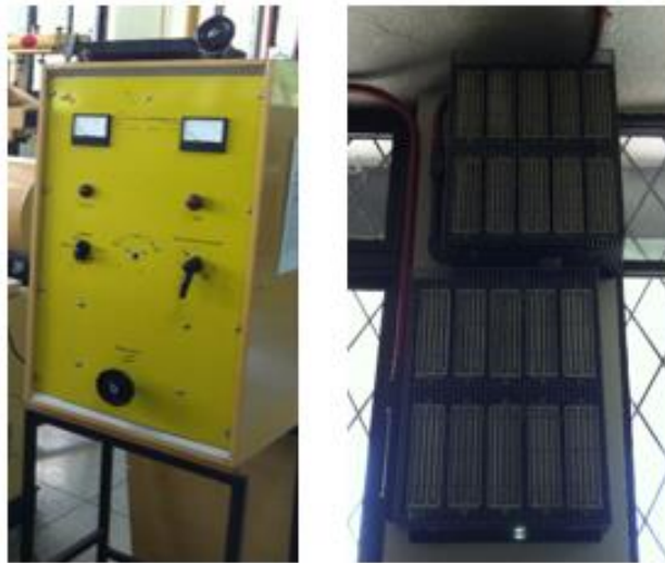
Figura 2.18. Tablero de control y resistencias eléctricas del sistema de freno
