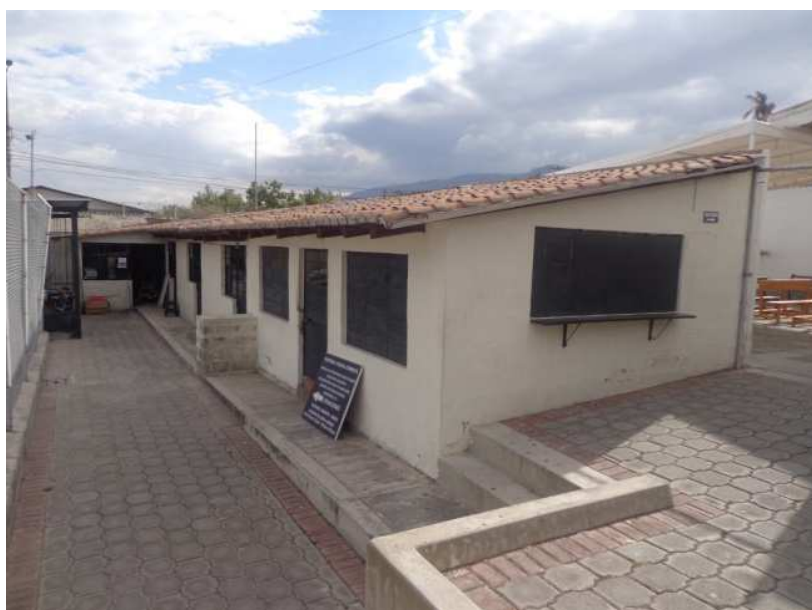
Figura 6: Fachada frontal Centro de información
