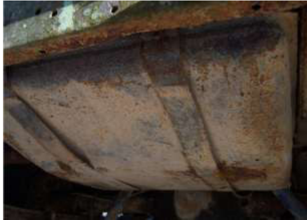
Figura 109 Tanque De Combustible
