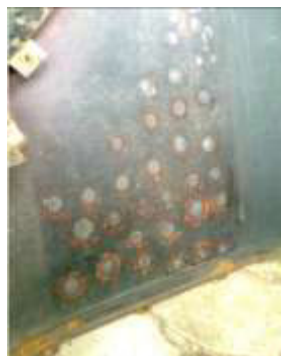
Figura 161 Proceso De Aplanado Mediante El Calentamiento Y Golpes Continuos Del Material.
