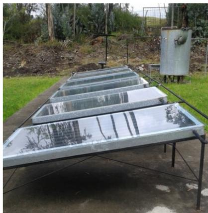
**Figura 6: Campo de colectores Solares para calentamiento del compost.**
