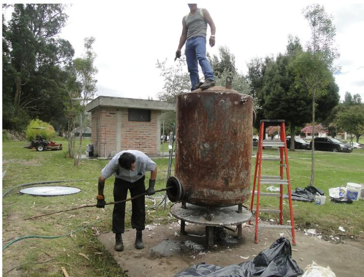
**Figura 9: Limpieza interior para verificación del estado interno del reactor**
