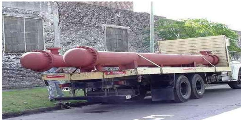
**Figura 23: Intercambiadores de Casco y Tubo**
