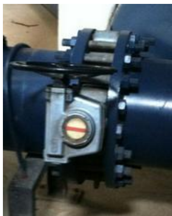
Figura 45. Válvula mariposa para control de caudal, 400 mm
