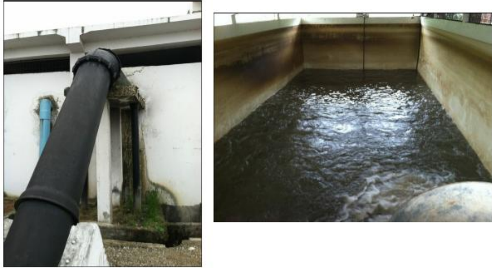
Figura 7 Tanque de almacenamiento en Río de Oro. Capacidad 1000 m 3
