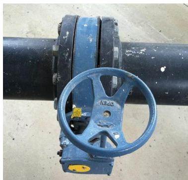
Figura 43 Válvula de mariposa usada para el control de caudal
