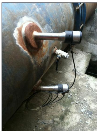
Figura 38 Sensor de caudal Siemens SONO 3100
