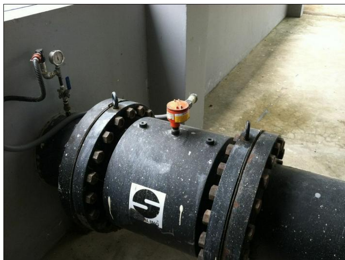
Figura 36 Sensores de presión y caudal Sparling, modelo FM656
