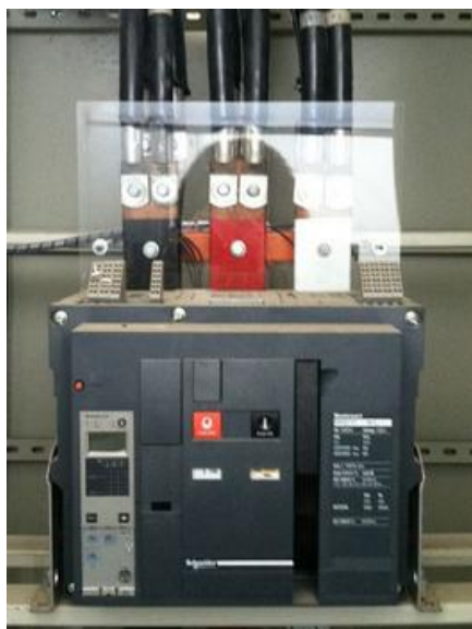
Figura 105. Interruptor automático, Masterpact Schneider
