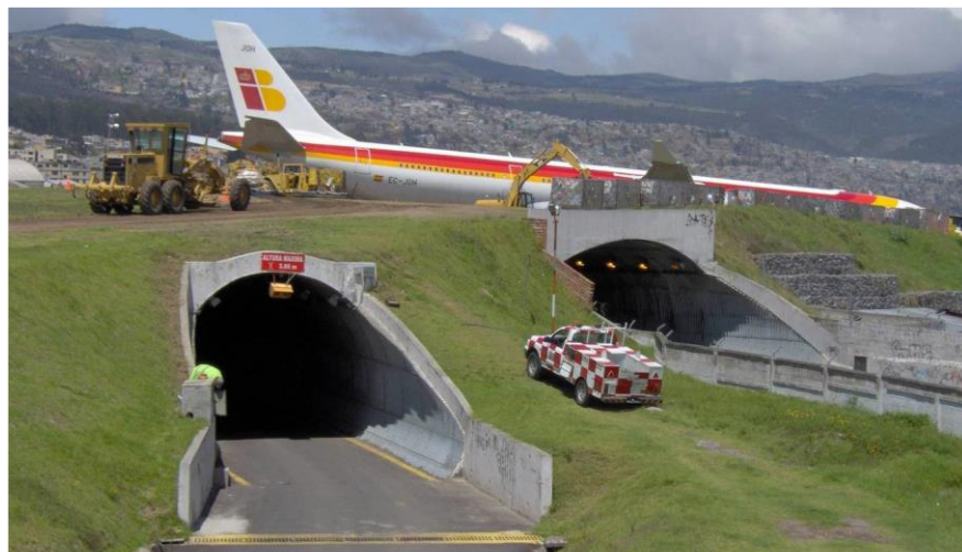
Figura 2-22 Carga de Maquinaria Pesada y Avión sobre conductos Av. Luis Tufiño (Samaniego, 2007)
