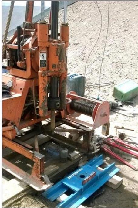
**Figura 3.9.** Perforación del suelo
