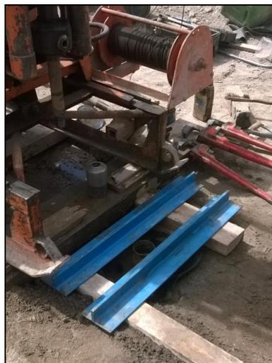
**Figura 3.14.** Instalación de las vigas de reacción
