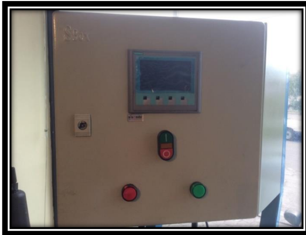
FIGURA 70 Montaje de KTP 400, luces y botonera
