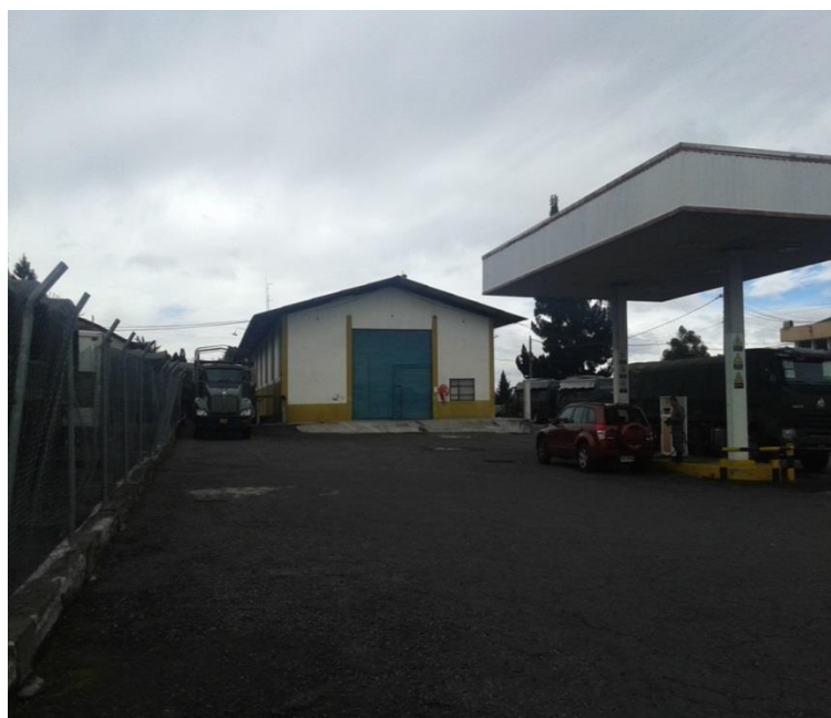
Figura13, Área de carga combustible.
