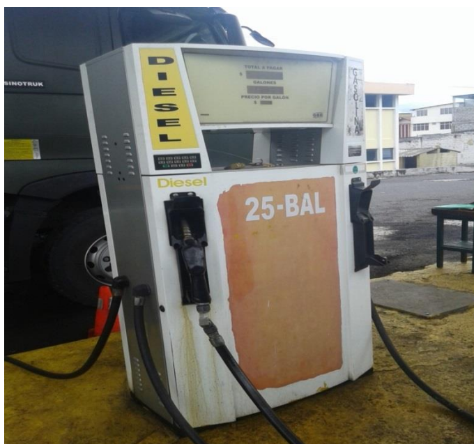
Figura12 Área de despacho de combustible obsoleto y que termino su vida útil.
