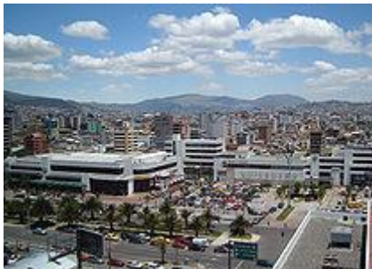
Ilustración 4: Centro Comercial Quicentro - Quito
