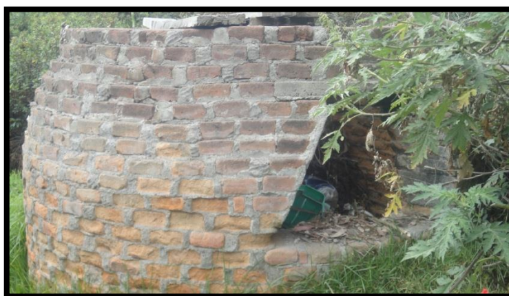
Figura 53. Horno de quema de residuos Hostería la Ciénega
