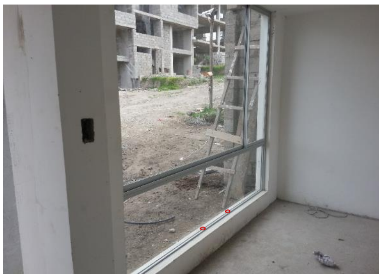
Figura 48. Colocación de ventanales Proyecto 1.
