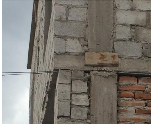
Figura 98. Columnas discontinuas en una vivienda.
