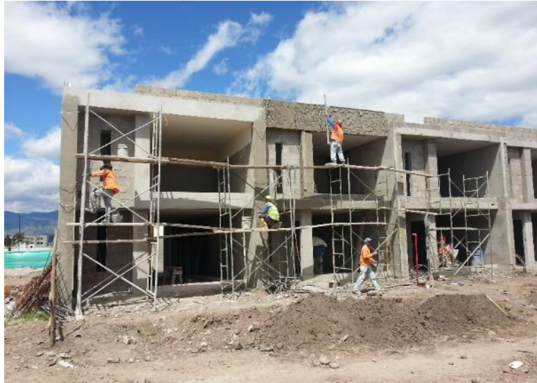
Figura 36. Proceso de enlucido con máquina proyectora.
