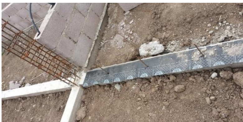
Figura 35. Impermeabilización y arriostramiento de mampostería proyecto 2.
