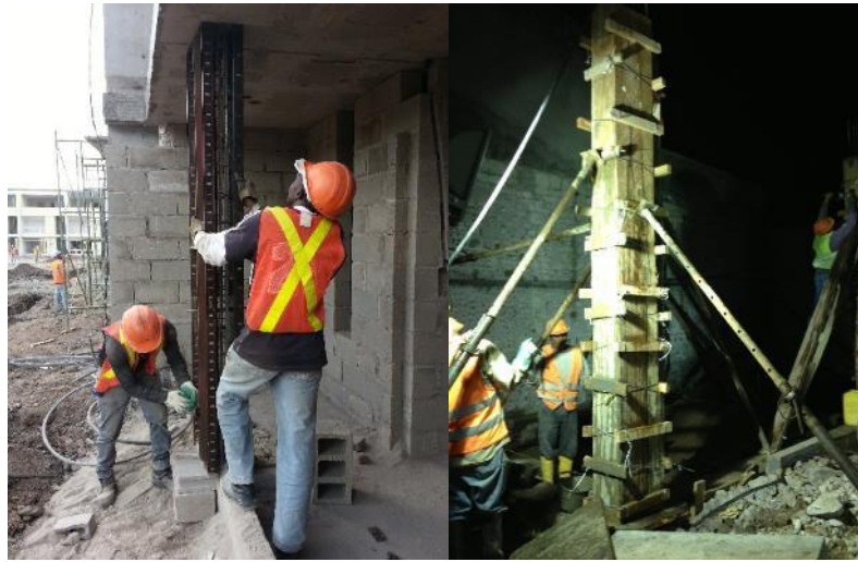
Figura 31. Fundición de columnas.
