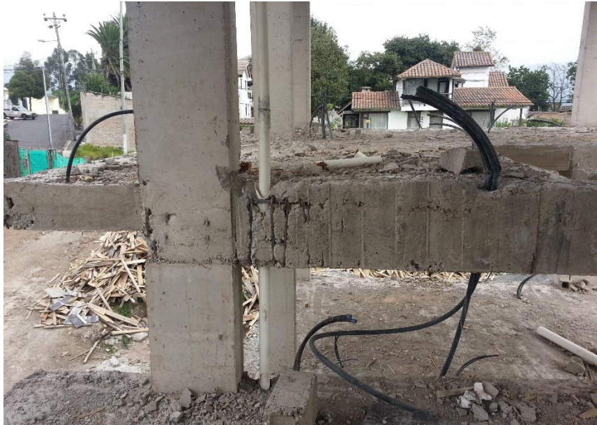
Figura 32. Vigas fundidas en el Proyecto 1.
