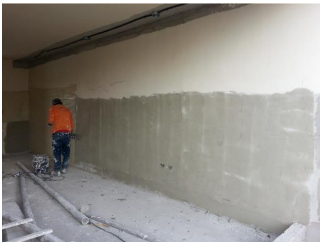
Figura 37. Proceso de estucado Proyecto 4.
