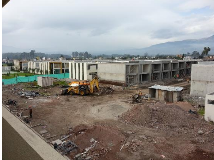
Figura 29. Vista del proyecto 4.
