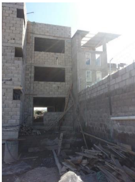
Figura 28. Vista del Proyecto 3.
