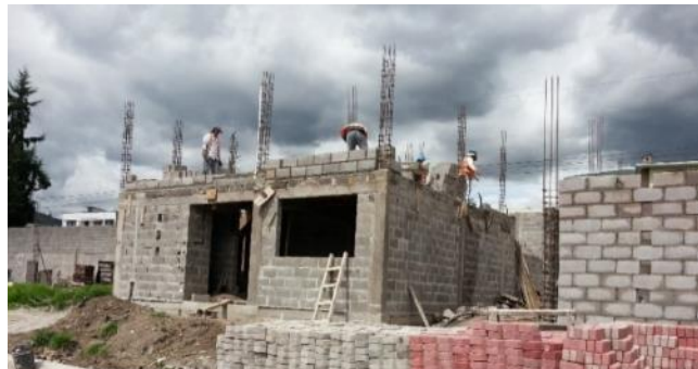
Figura 34. Colocación de Mampostería Proyecto 2.
