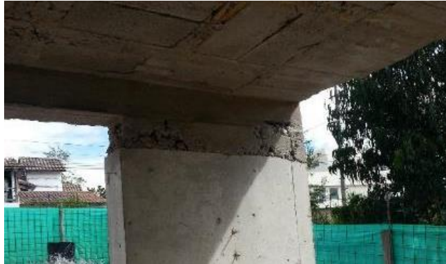
Figura 40. Discontinuidad nudos en una estructura.
