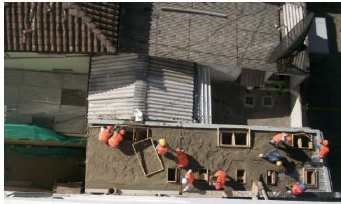
Figura 33. Fundición de Losas.
