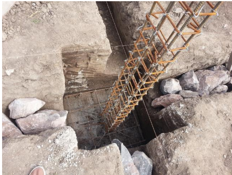
Figura 30. Fundición de cimentaciones Proyecto 2.
