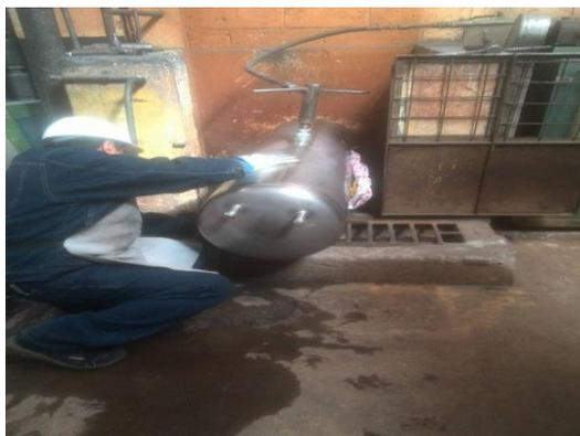
**Figura 74.** Verificación de Fugas
