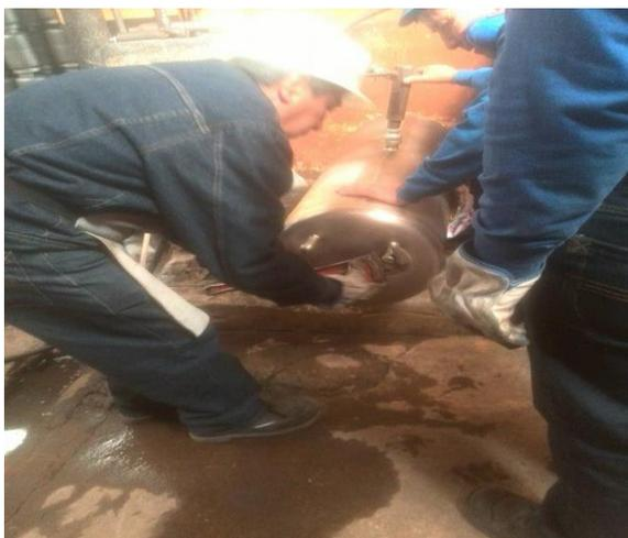
**Figura 70.** Colocación de tapones prueba hidrostática
