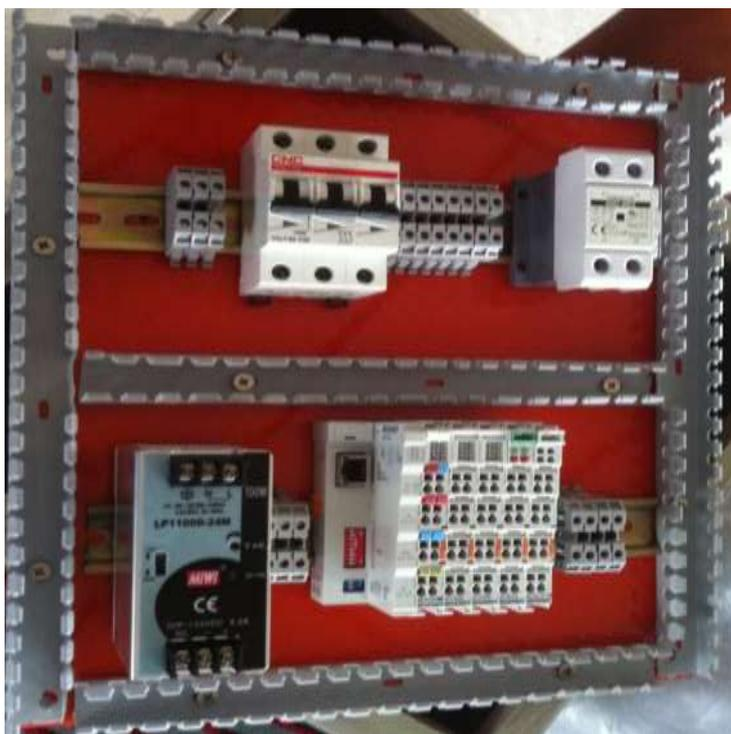
**Figura 57 Rieles y Elementos de Potencia, Control**
