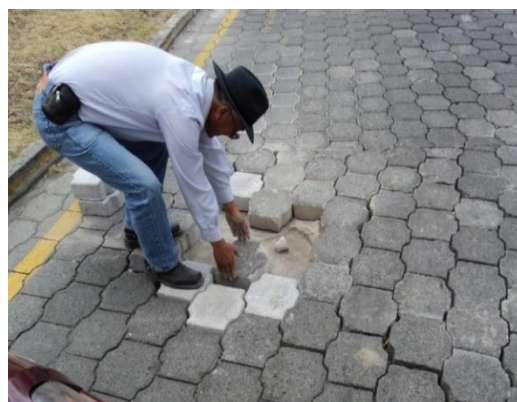
Figura 33. Reposición de Adoquines.
