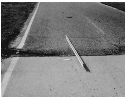
Figura 16. Falla tipo Desplazamiento
