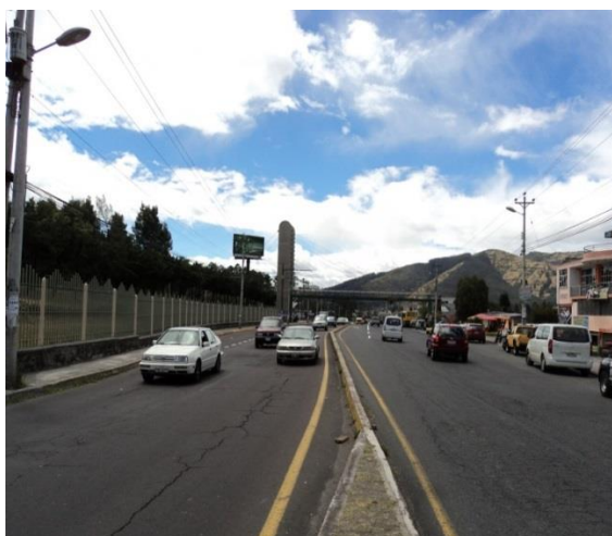
Figura 36. Tramo de estudio Pavimento Flexible.
