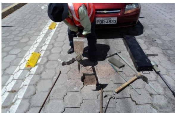
Figura 62. Proceso de excavación.
