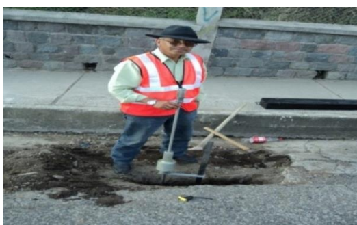
Figura 65. Lugar de excavación.
