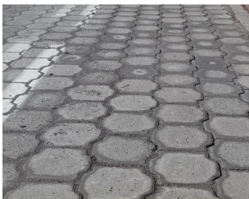
Figura 23. Falla Tipo Perdida de Arena.
