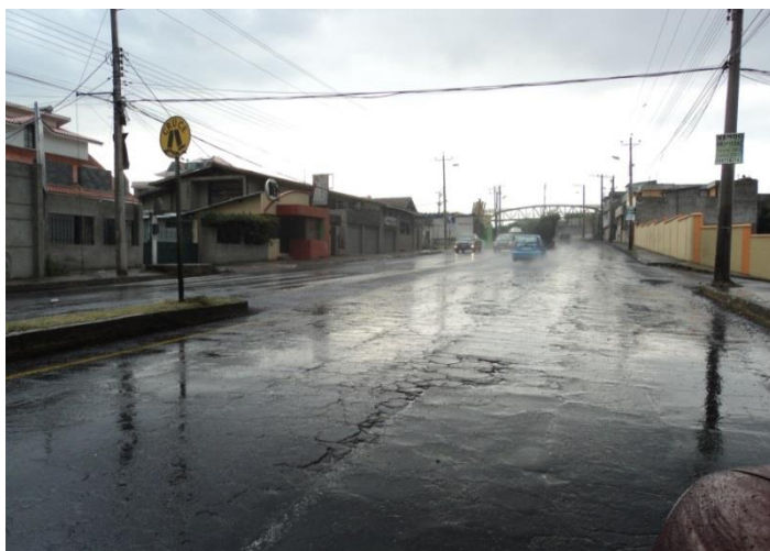
Figura 119. Daño representativo surco de huella
