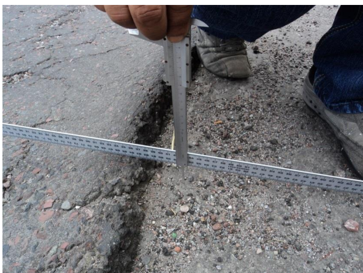
Figura 115. Daño representativo tipo Desnivel Carril - berma
