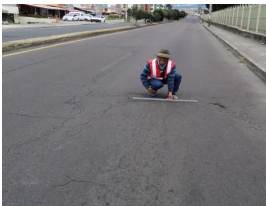
Figura 17. Grietas Parabólicas.
