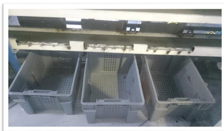
Figura 86. Prueba de detección de gavetas.
