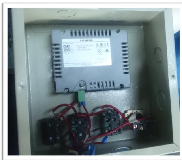
Figura 78. Panel de control – Vista posterior.
