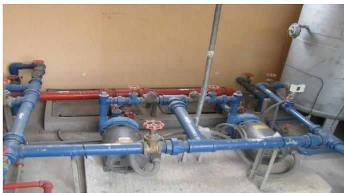
**Figura 145 Sistema de bombas de agua – cisterna**
