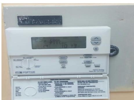
**Figura 176 Sist. de control y termostato -aire acondicionado en oficinas**
