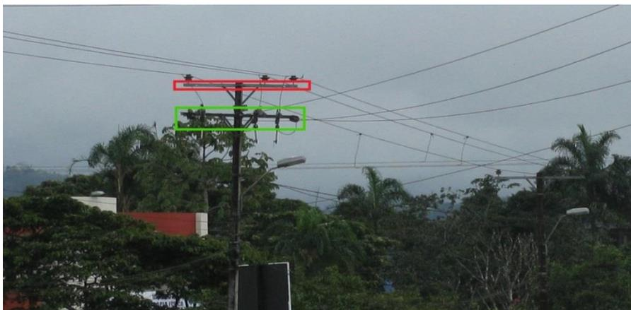
**Figura 27 Poste seccionador manual alimentador N° 2122 y N°2121**
