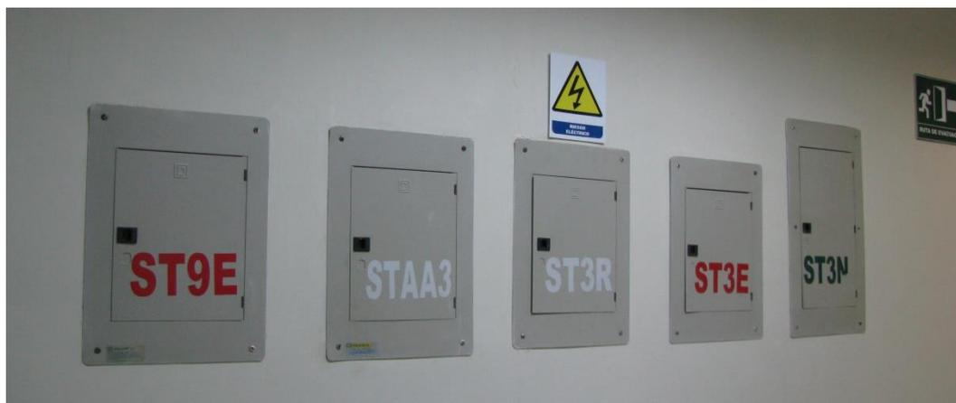
**Figura 142 Sub tableros de distribución de en el área de emergencia.**
