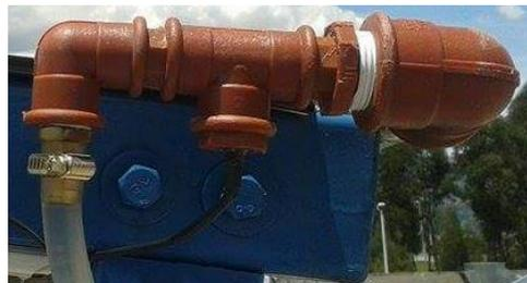
**Figura 101** Instalación de accesorios del circuito de distribución.
