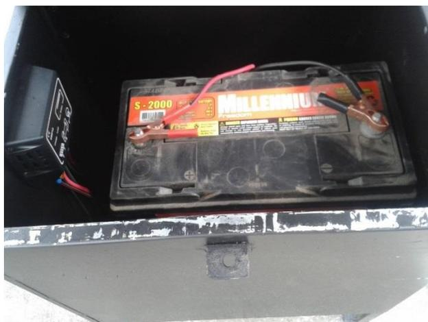
**Figura 117** Ubicación y conexión de la batería y el regulador dentro de la caja.
