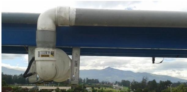
**Figura 102** Vista frontal del soplador.
