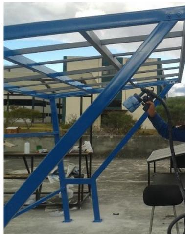
**Figura 97** Pintado de la estructura con soplete.
