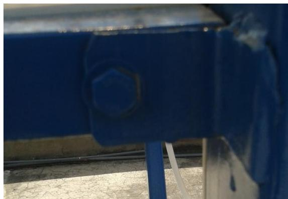
**Figura 93** Conexión apernada de un tubo horizontal con el larguero.
