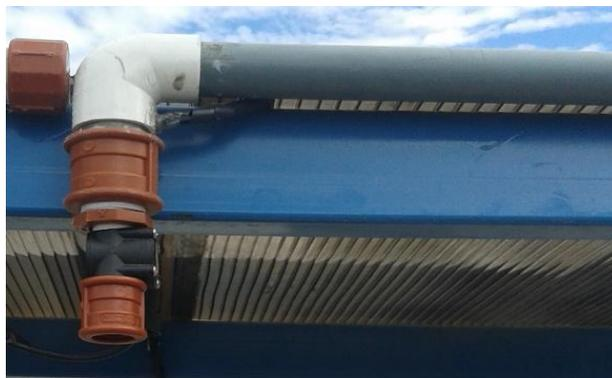
**Figura 104** Conducto de salida de la instalación para ventilación.
