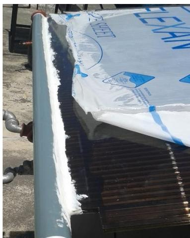
**Figura 87** Pegado de un colector solar.
