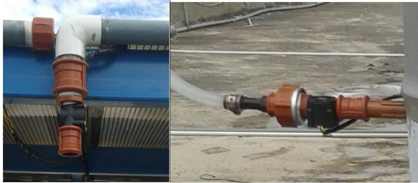
**Figura 108** Instalación de caudalímetros.
