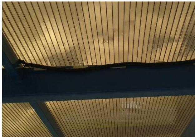
**Figura 107** Instalación de sensores de temperatura superficial de la placa.
