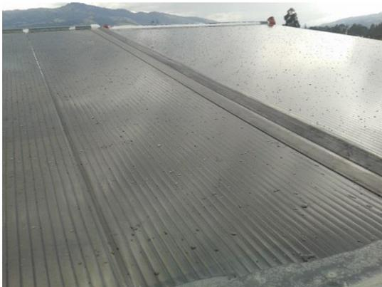
**Figura 98** Instalación de las planchas de policarbonato con uniones.
