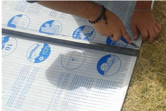
**Figura 84** Corte de la plancha de policarbonato alveolar con estilete afilado.
