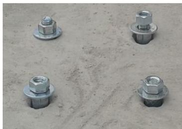
**Figura 95** Taladrado y colocación de pernos de expansión en el piso.
