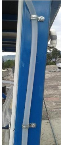
**Figura 100** Instalación de la manguera flexible de PVC
