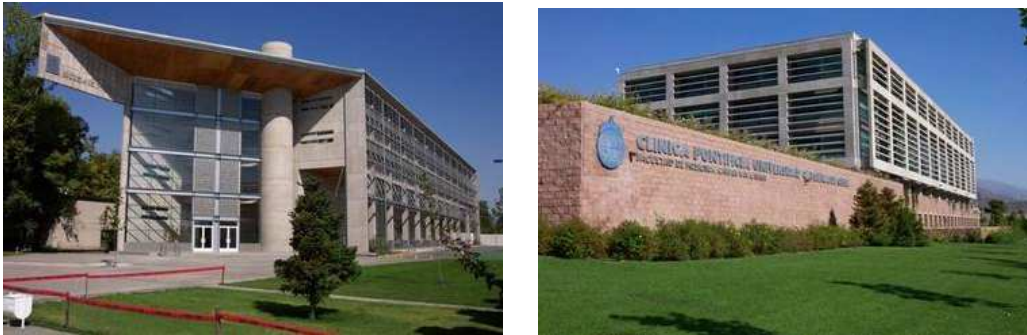
Figura 1.12 Edificio San Agustín y Clínica San Carlos construidos con aisladores de base
