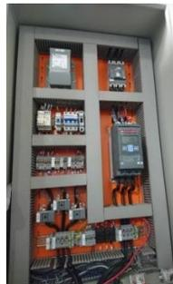
**Figura 26.** Elementos de protección Interruptores Termo Magnéticos
