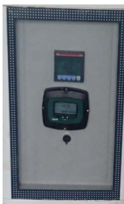
**Figura 16.** Visualizador LCD Magflux y medidor de parámetros eléctricos
