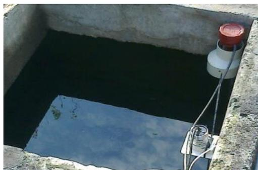
**Figura 17.** Sensor ultrasónico y Switch de nivel, Gate 8
