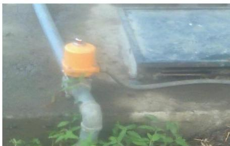
**Figura 22.** Actuador rotatorio BELIMO, Cuarto de Bombas
