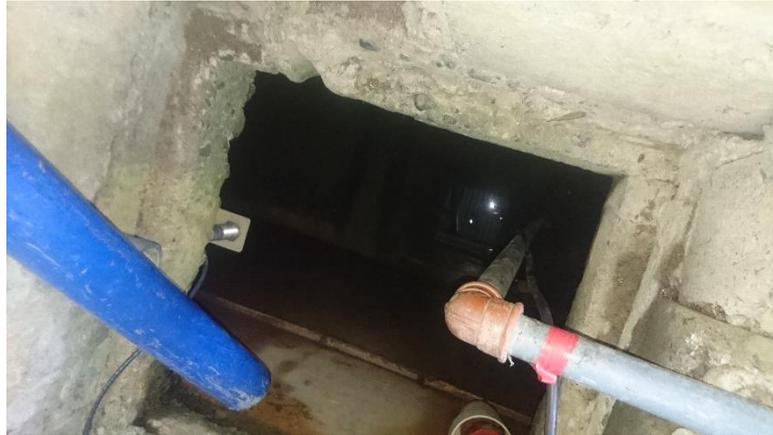
**Figura 18.** Sensor ultrasónico y Switch de nivel, Reservorio Calime
