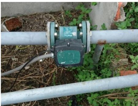
**Figura 15.** Medidor de Flujo MJK,, Magflux, Estación de Bombeo
