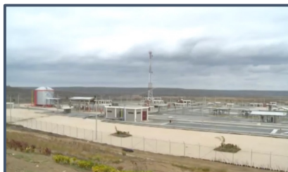
Figura 3. Estación de Bombeo de Monteverde
