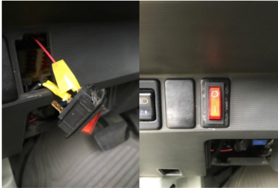
Figura 50 Accionamiento del variador Spark 11
