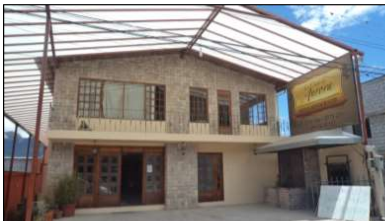
Figura 32. Hotel Restaurante Casa de Aurora.
