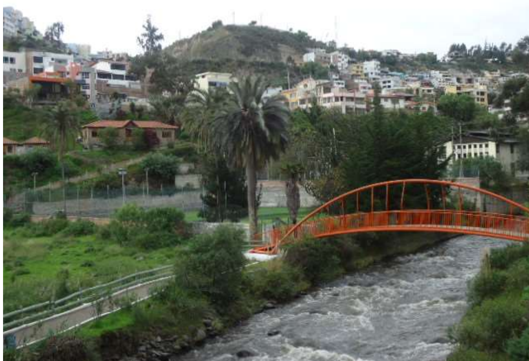
Figura 25 Vista de parte del paseo ecológico de la ciudad de Ambato
