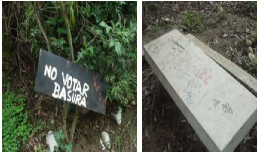
Figura 5 Daño a la infraestructura del paseo ecológico
