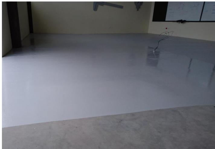
**Figura No. 48. Aplicación de la pintura de alto tráfico en los laboratorios**
