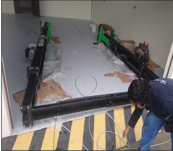
Instalación de los elevadores en el laboratorio de Autotrónica
