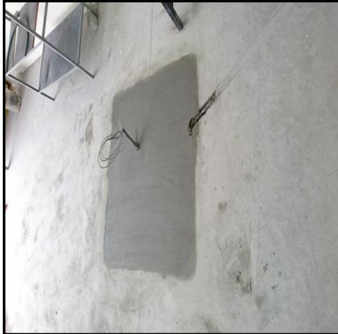
Las mayas ya colocadas en el interior y cubiertas cubiertas con concreto con una profundidad de 1m y area de 1m<sup>2</sup> suficiente para tener la correcta profundidad para la instalación de las bases de los elevadores ya que las especificaciones indican que tiene que sobrepasar los 20 cm de profundidad para una instalación correcta
