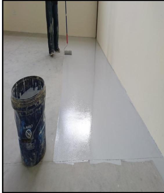
Colocación de la pintura de alto tráfico en las instalaciones del laboratorio de Autotrónica en los laboratorios 1,2,3
