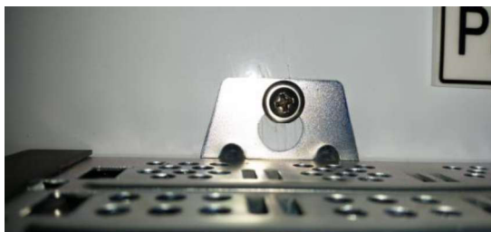
Figura 96. Sujeción del chasis para PLC al panel doble fondo.
