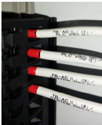
Figura 103. Conexionado del bloque de terminales de AC.
