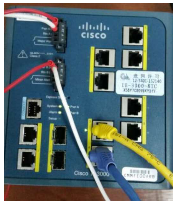
Figura 126. Prueba de energización y verificación de puertos Ethernet en switch CISCO (2).
