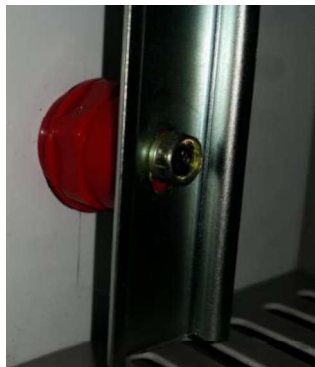
Figura 95. Ajuste de riel DIN al aislante tipo barril.
