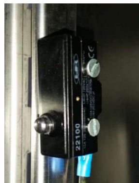
Figura 122. Colocación del micro switch al gabinete metálico.
