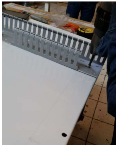
Figura 92. Colocación de canaleta plástica mediante autoperforantes.
