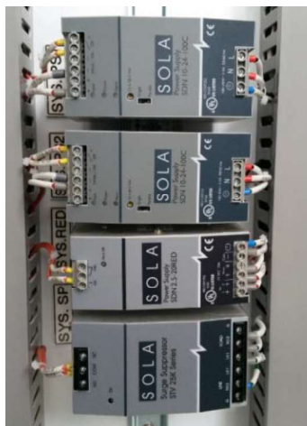
Figura 105. Conexión de fuentes SOLA.
