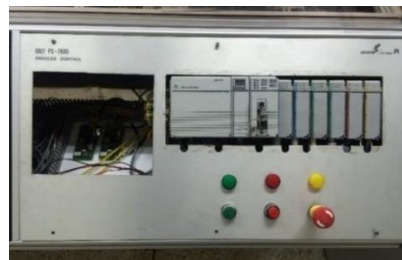
Figura 34. Maquinado del tablero de control
