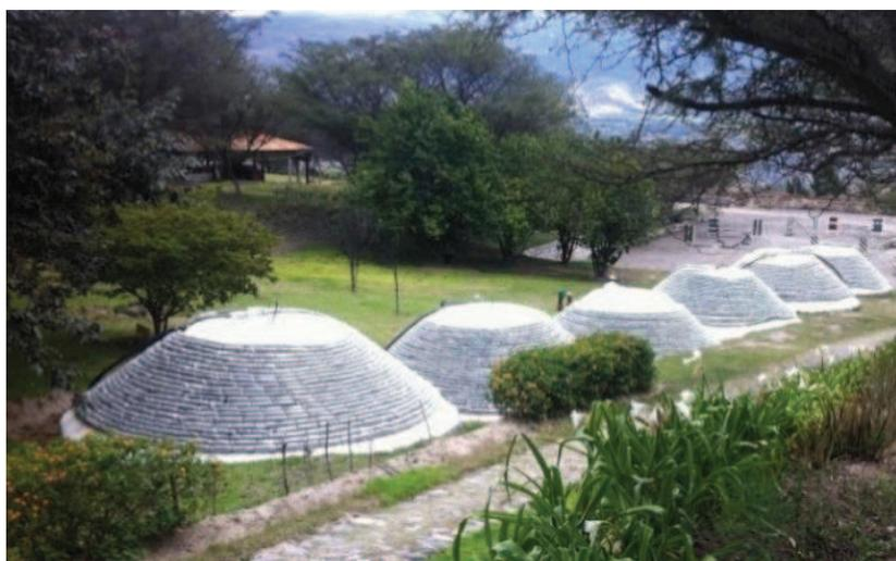
**Figura 1 Colectores cónicos solares en Pimán (Tunas y Cabras)**
