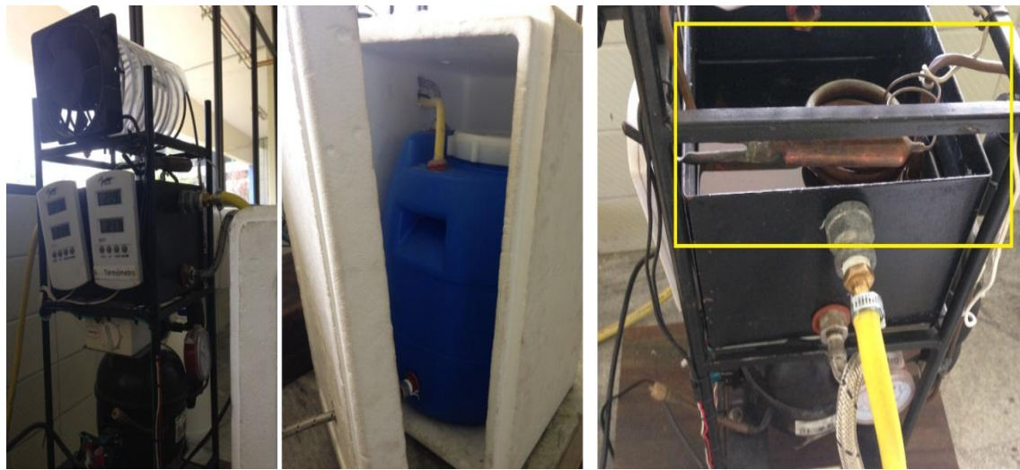
Figura 108. Encendido del sistema de refrigeración
