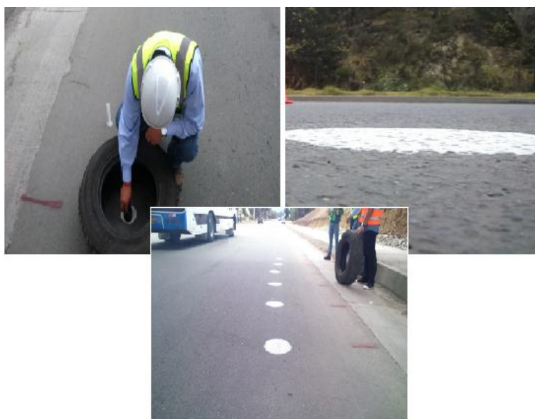
Figura 26. Ensayo de Mancha de Arena Tramo Cuenca – Azogues
