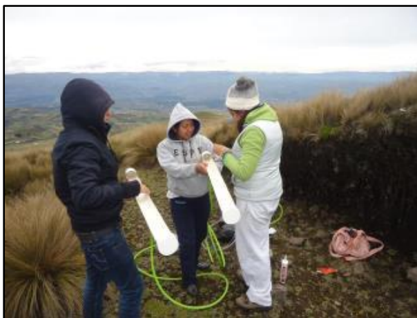
Figura 31. Construcción de canaletas de los atrapanieblas
