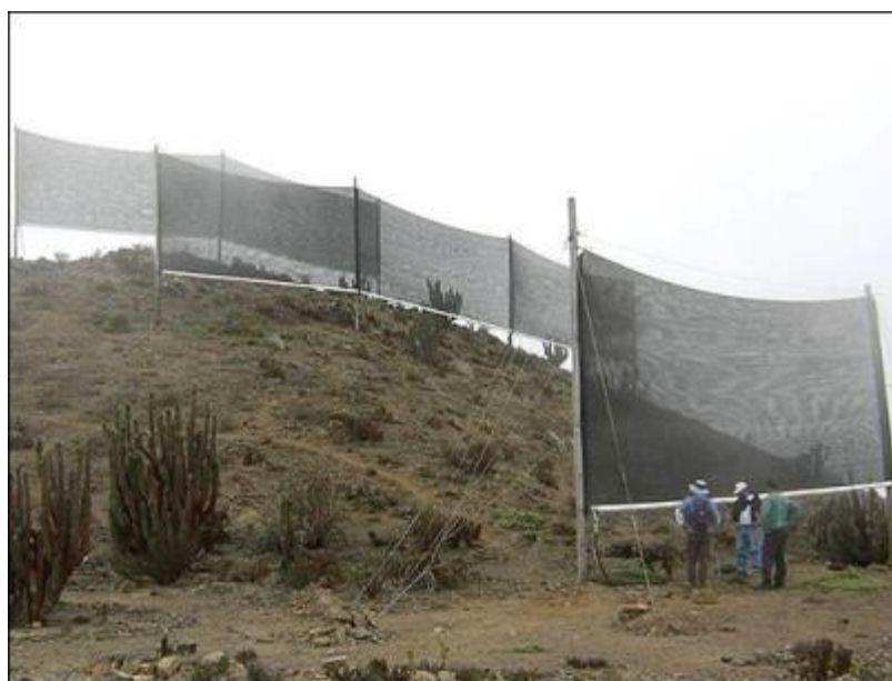
Figura 4. Atrapanieblas en Falda Verde, cerca de Chañaral, en el norte de Chile.
