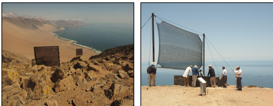
Figura 8. En el desierto de Atacama en Chile, se usa malla de polipropileno para capturar la niebla que rueda en la costa.
