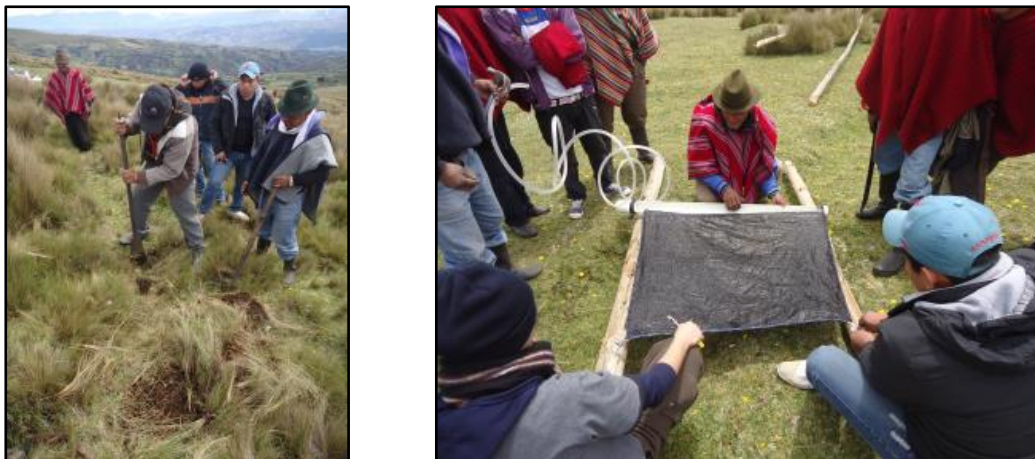
Figura 32. Moradores cavando los huecos y colaborando en el tensado de la malla
