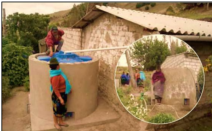
Figura 14. Recolección de agua lluvia
