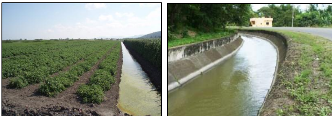
Figura 13. Zanjas de drenaje para captación de agua.
