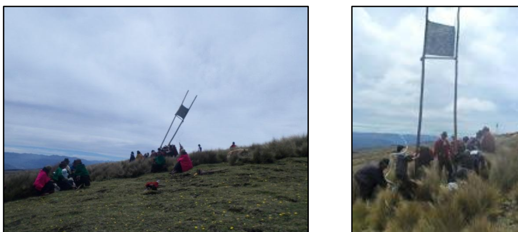
Figura 33. Colocación del Sistema Atrapanieblas
