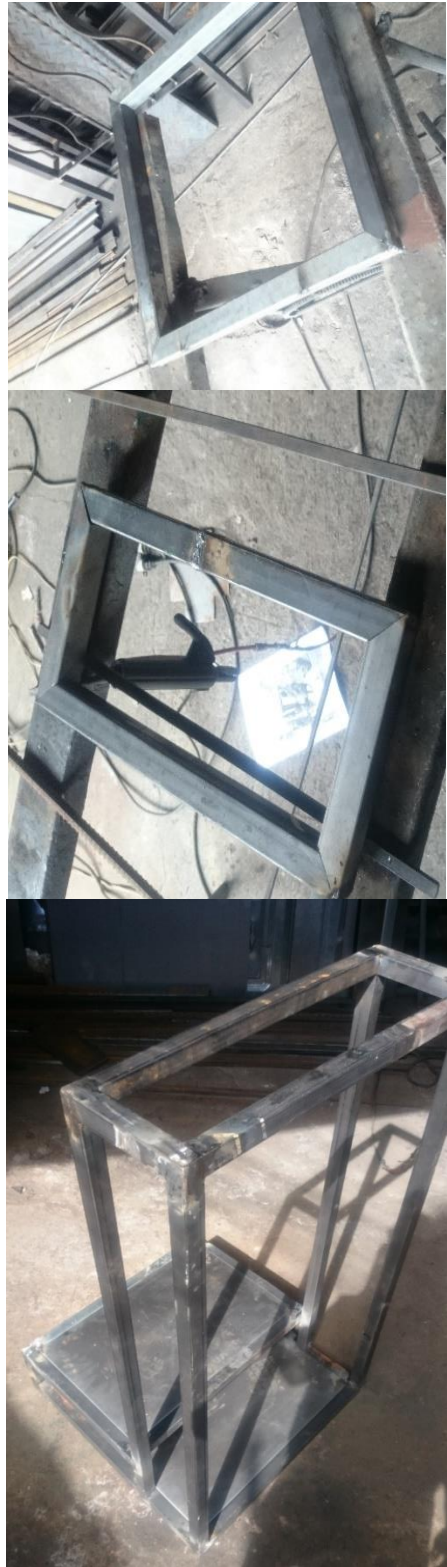
Figura 89. Fases de la construcción de la estructura base principal.
