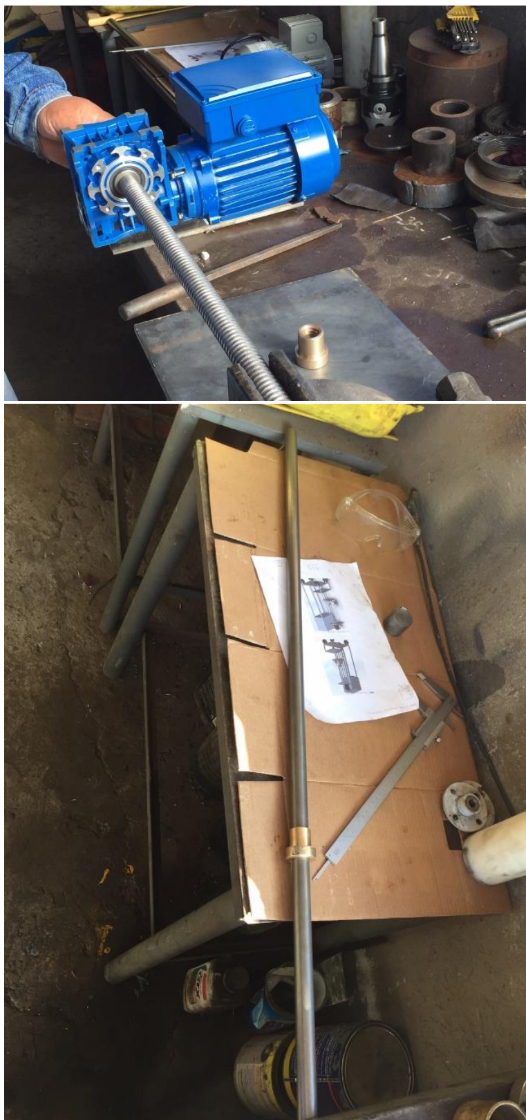
Figura 86. Fase 1 de la construcción de la estructura del elevador.
