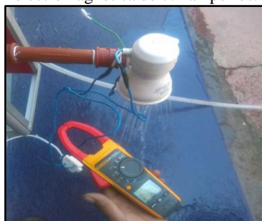
Figura 206 Medición de corriente de entrada ducha eléctrica.
