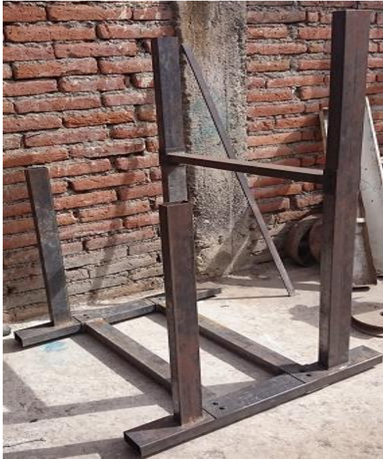
Construcción estructura del Módulo.
