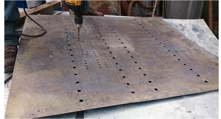
Proceso de perforado tablero de control.
