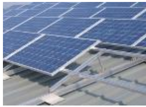
Figura 31 Estructura soporte sobre el tejado
