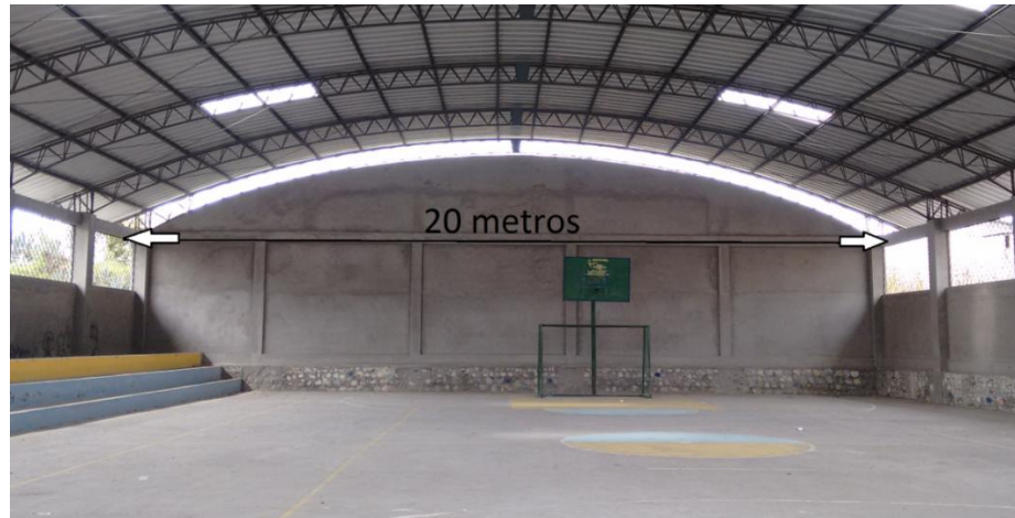
Figura 40 Tubo redondo en la estructura
