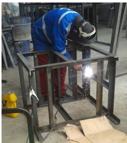
Figura 51 Estructura de la mesa
