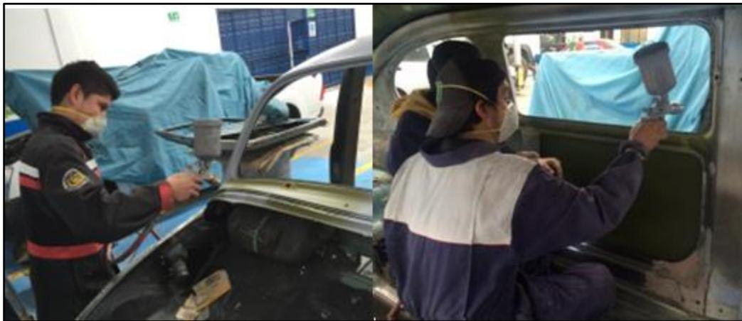
**Figura 99 Aplicación de capa del promotor de adherencia**
