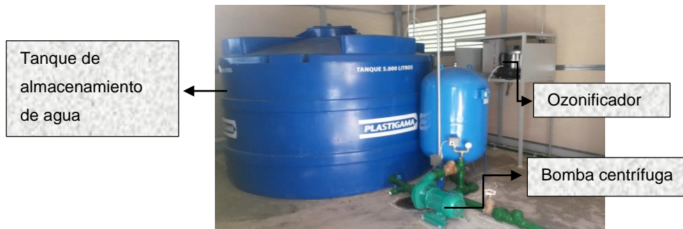
Figura 2 Planta de potabilización de agua.
