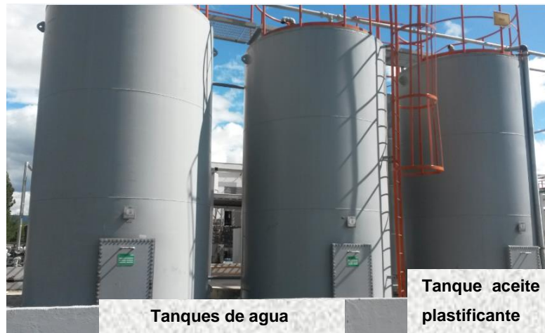
Figura 6 Tanques de almacenamiento aceite térmico y agua para los procesos de producción
