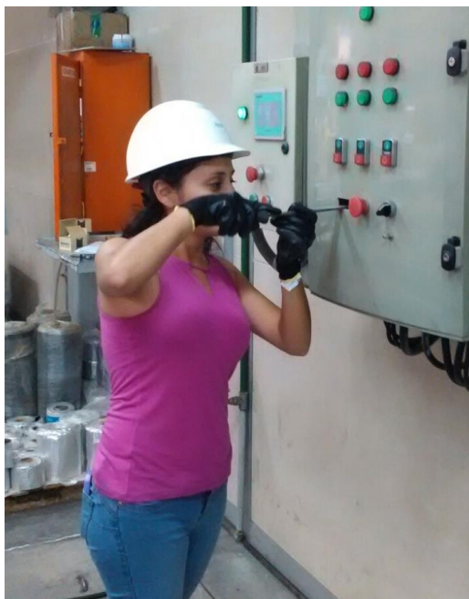
Figura 69 Perforación de tablero eléctrico
