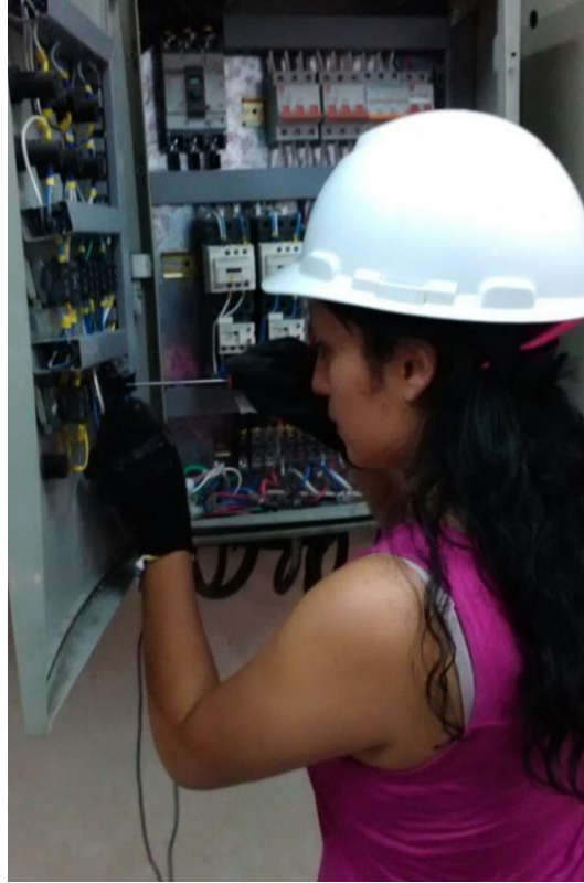
Figura 70 Instalación de horómetro en Tablero Eléctrico.
