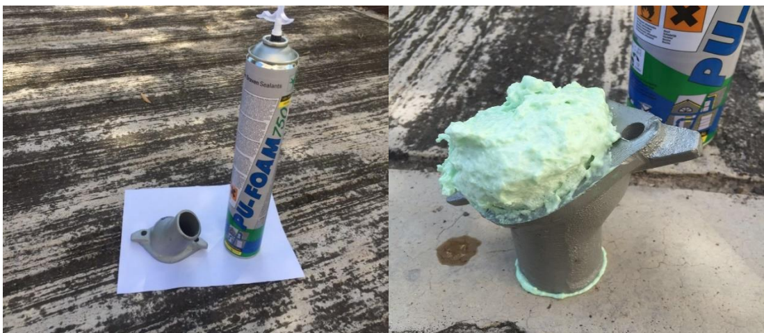
Figura 36: Obtención de Forma interna de ducto.
