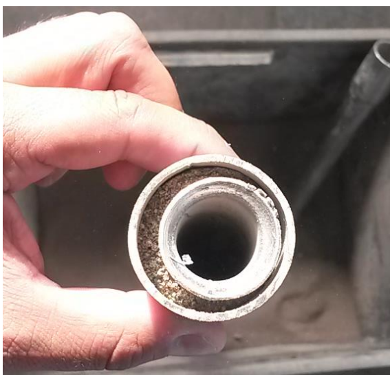
Figura 42. Tubería posterior al llenado y compactado de arena
