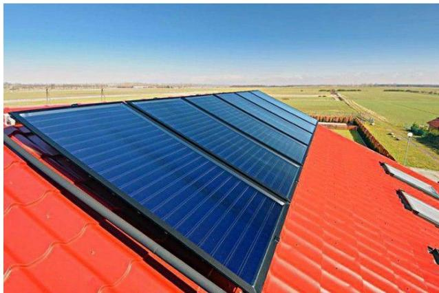
**Figura 8 Panel solar térmico**
