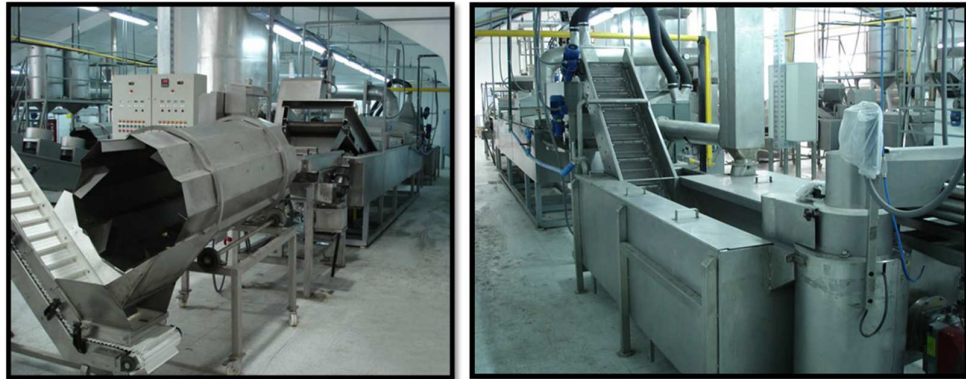
Figura 16 Estación saborizado (izq.) banda transportadora (dcha.)
