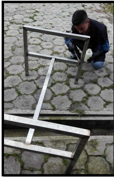
Figura 156 Estructura banda transportadora
