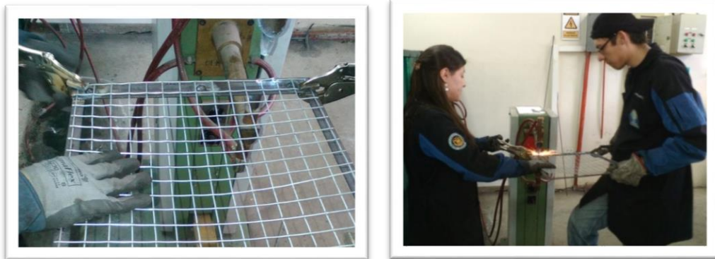
Figura 47 Construcción de malla para protección.
