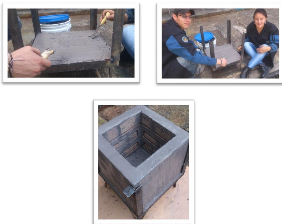
Figura 40 Armado de las paredes del horno en la estructura metálica
