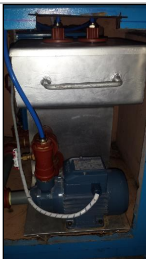
Figura 135 Prueba de la bomba electrohidráulica y los reguladores de caudal.
