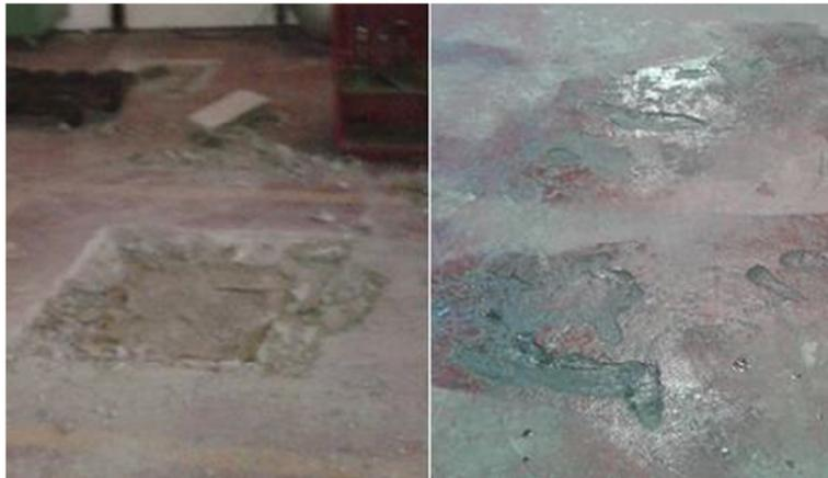
**Figura 26. Piso agrietado y deteriorado – Antes.**
