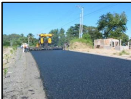
Figura 140. Extensión de mezcla drenante.
