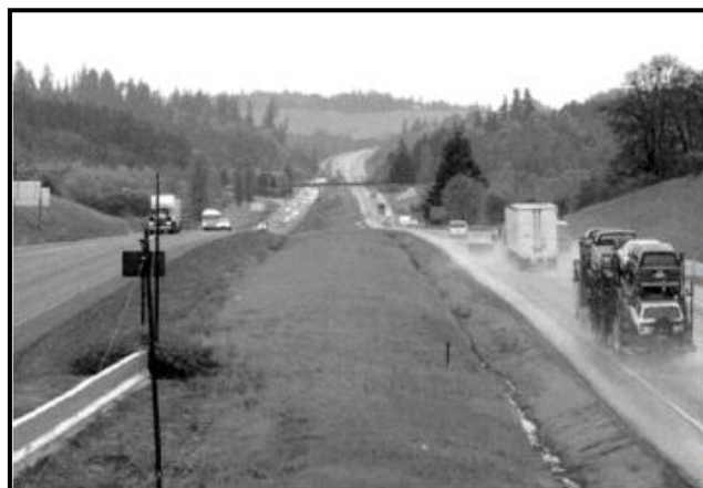
Figura 127. Oregón: (Derecha) mezcla asfáltica densa; (Izquierda) mezcla abierta.
