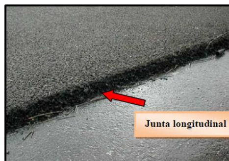
Figura 139. Junta longitudinal con un buen acabado.
