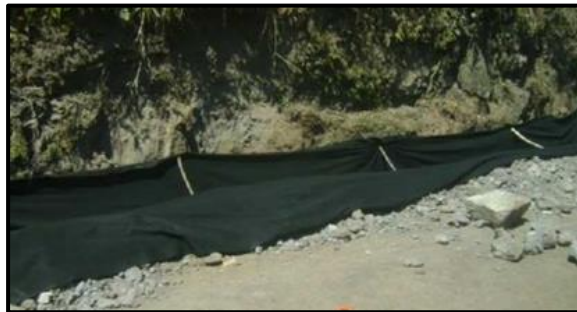
Figura 137. Geotextiles no tejidos que sirve de protección a las capas inferiores del pavimento.
