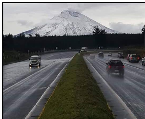
Figura 5. Tramo Jambelí – Latacunga, Km 34+840.
